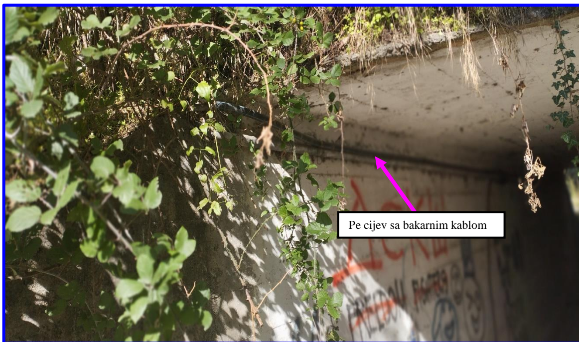
Sl.10: Pe cijev sa bakarnim kablom ankerisana ispod plafona podhodnika ispod magistrale. Slikano sa lijeve strane ulice od profila PR146 prema magistrali.
